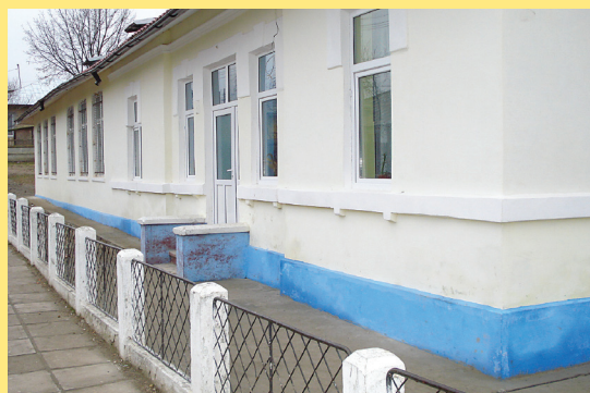
Grădinița Școlii nr. 2 a fost renovată
